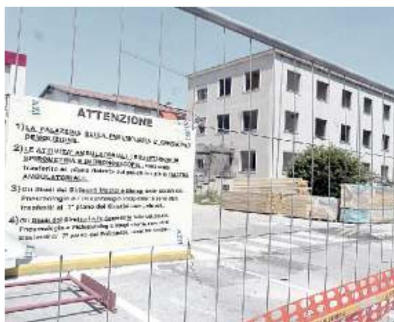
L'EDIFICIO Non è ancora iniziata la demolizione di Pneumologia
